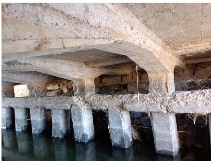
Foto N° 3 - Estructura existente. Pilas y estribos de columnas vinculadas con vigas. Se observan sectores con desprendimiento del recubrimiento.
