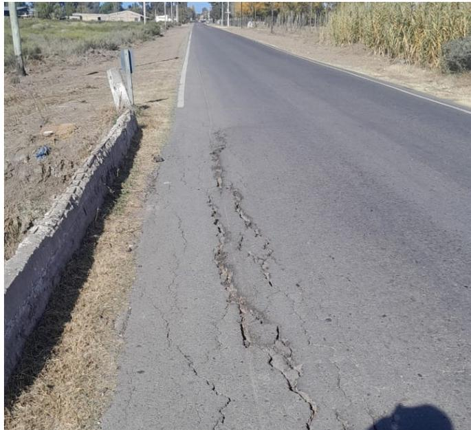
Foto N°1 - Agrietamiento inicial de la calzada, previo al colapso
