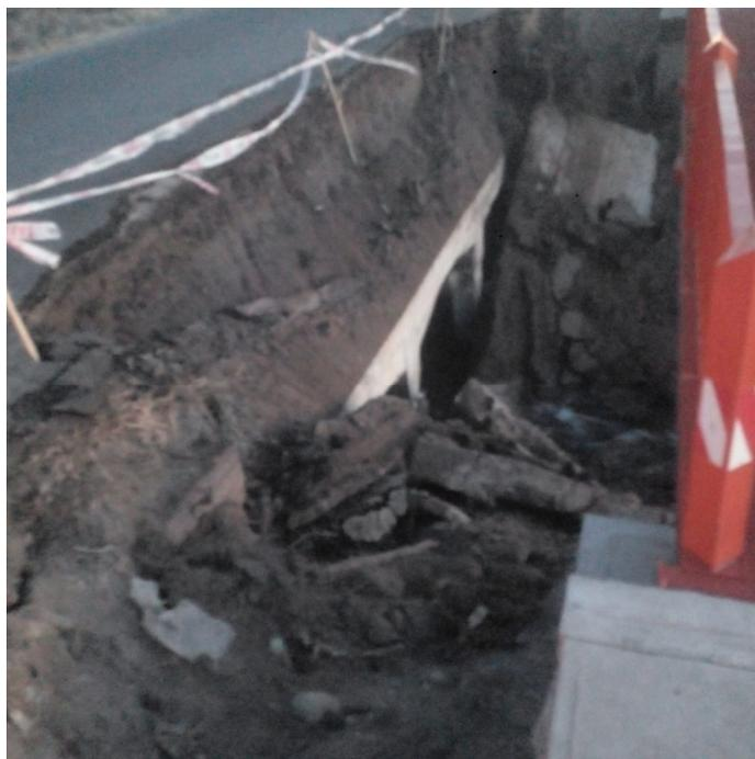
Foto N° 2 - Colapso del muro de contención – Se observa que el mismo no estaba conectado a la estructura existente, además se advierte una sobrecarga de tierra de gran espesor (aprox. 1.40 m) que exige sobremanera a la alcantarilla existente.
