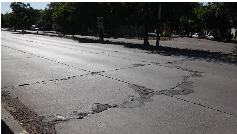
Foto: Deterioros actuales en Av. Costanera
