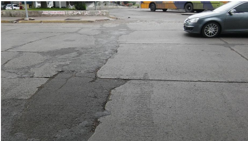
Foto: Deterioros actuales en Av. Costanera
