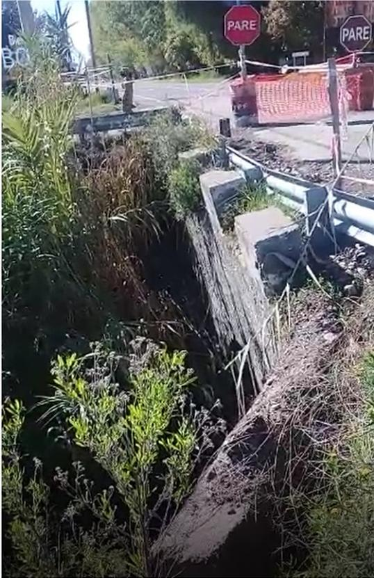
**Foto N° 2: Pérdida de verticalidad de muros cabeceros y muros de ala. Sistemas de defensas flexibles con falta de mantenimiento**
