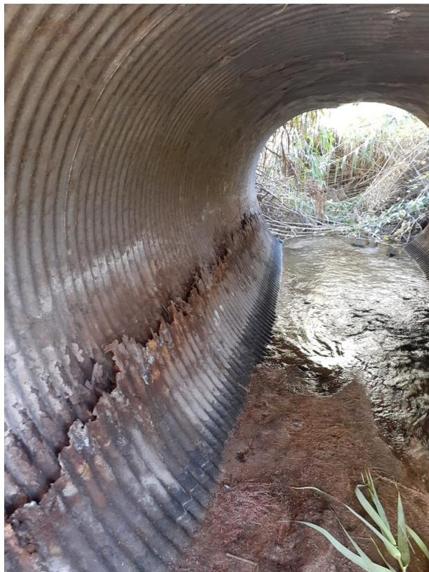
**Foto N° 1: Colapso parcial del costado derecho con deformación del intradós y pérdida de la geometría general.**
