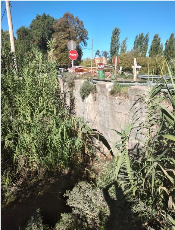
**Foto N° 3: La rotura de la alcantarilla metálica ha provocado el asentamiento del terraplén. En la imagen se visualiza el desplazamiento vertical que alcanza un máximo de 20 cm.**
