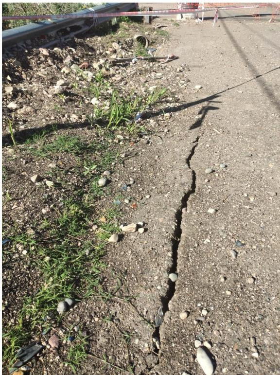
**Foto N° 4: Grave situación estructural en calzada. Los asentamientos han producido peligrosas grietas en superficie con rotura total de la capa asfáltica.**
