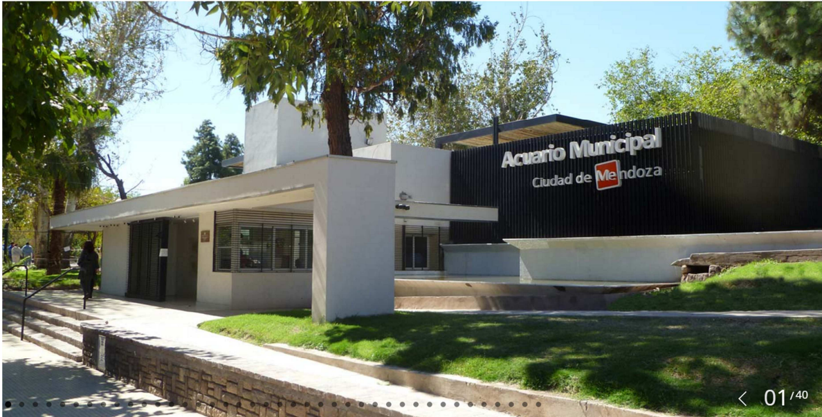
Vista del acceso, calle Ituzaingó
