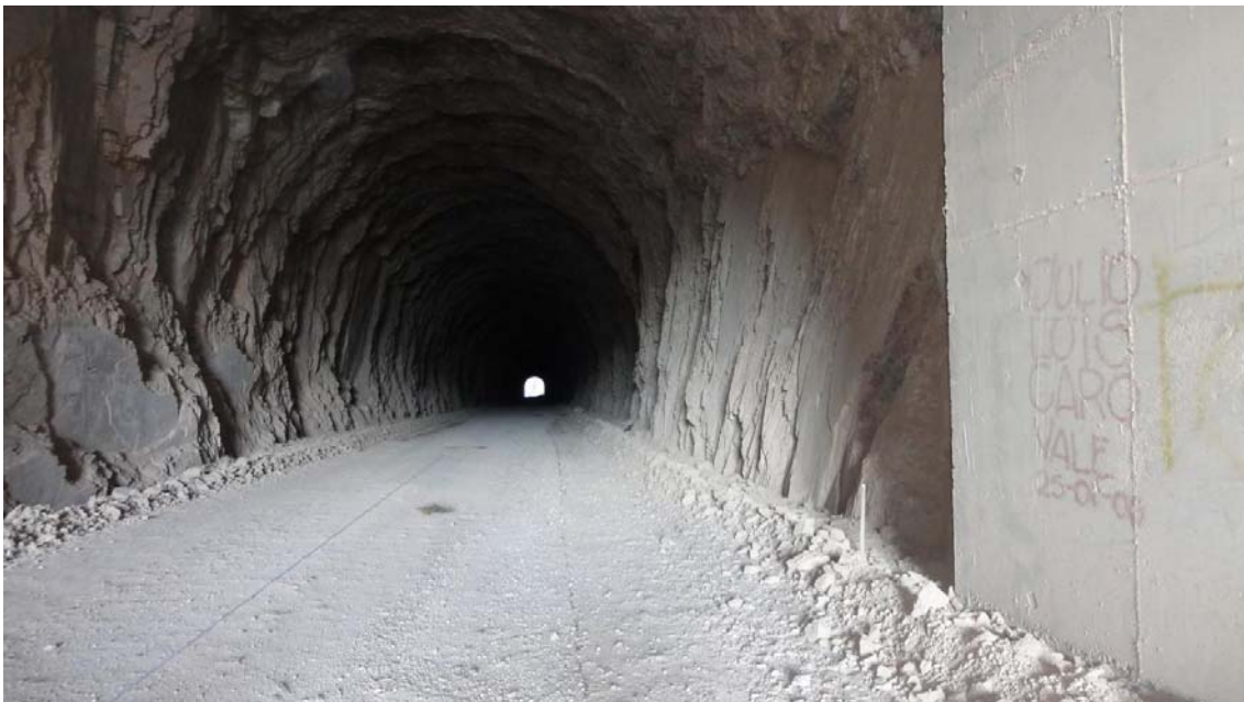
Vista del interior del Túnel
