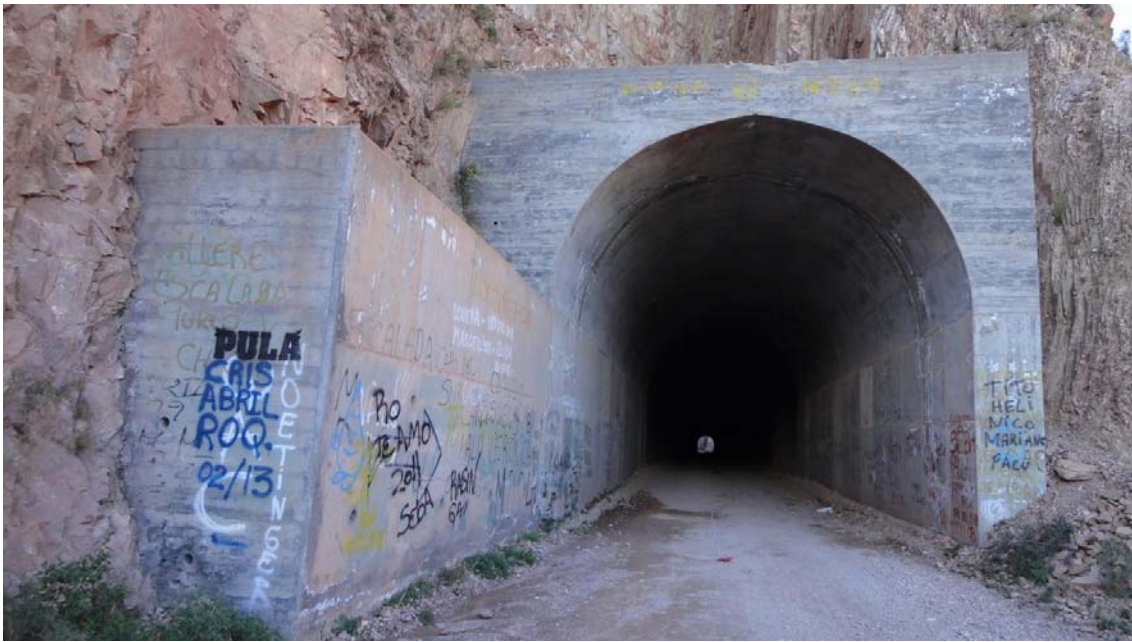
Vista del Portal Oeste del Túnel
