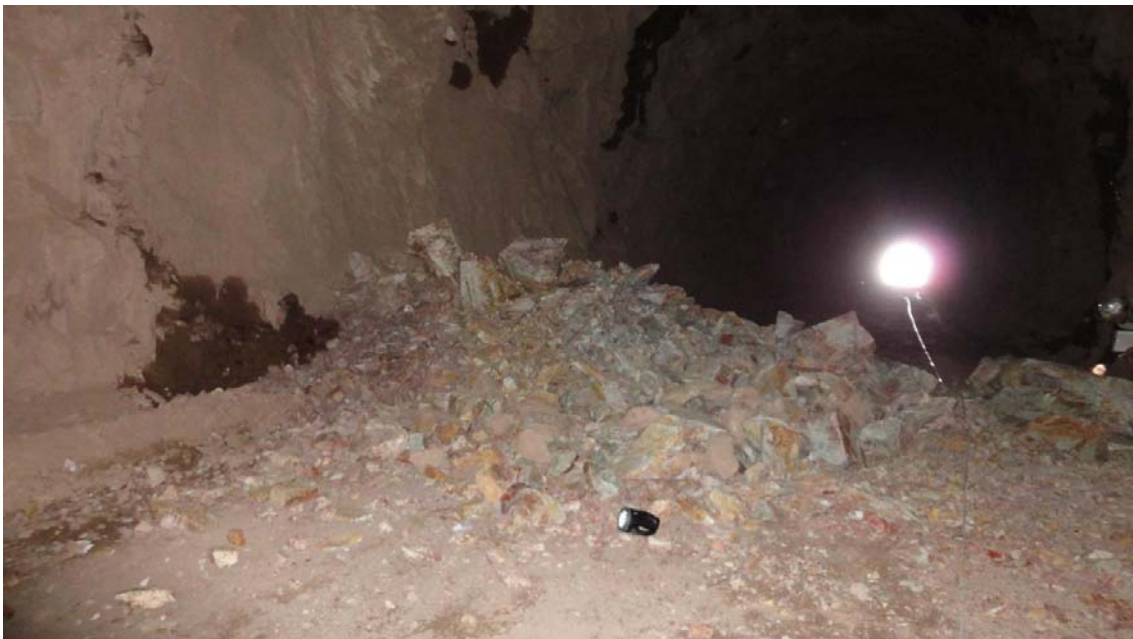
Vista del producto de derrumbe
